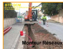
Monteur Réseaux 2007 OPCA AREF PACAC
